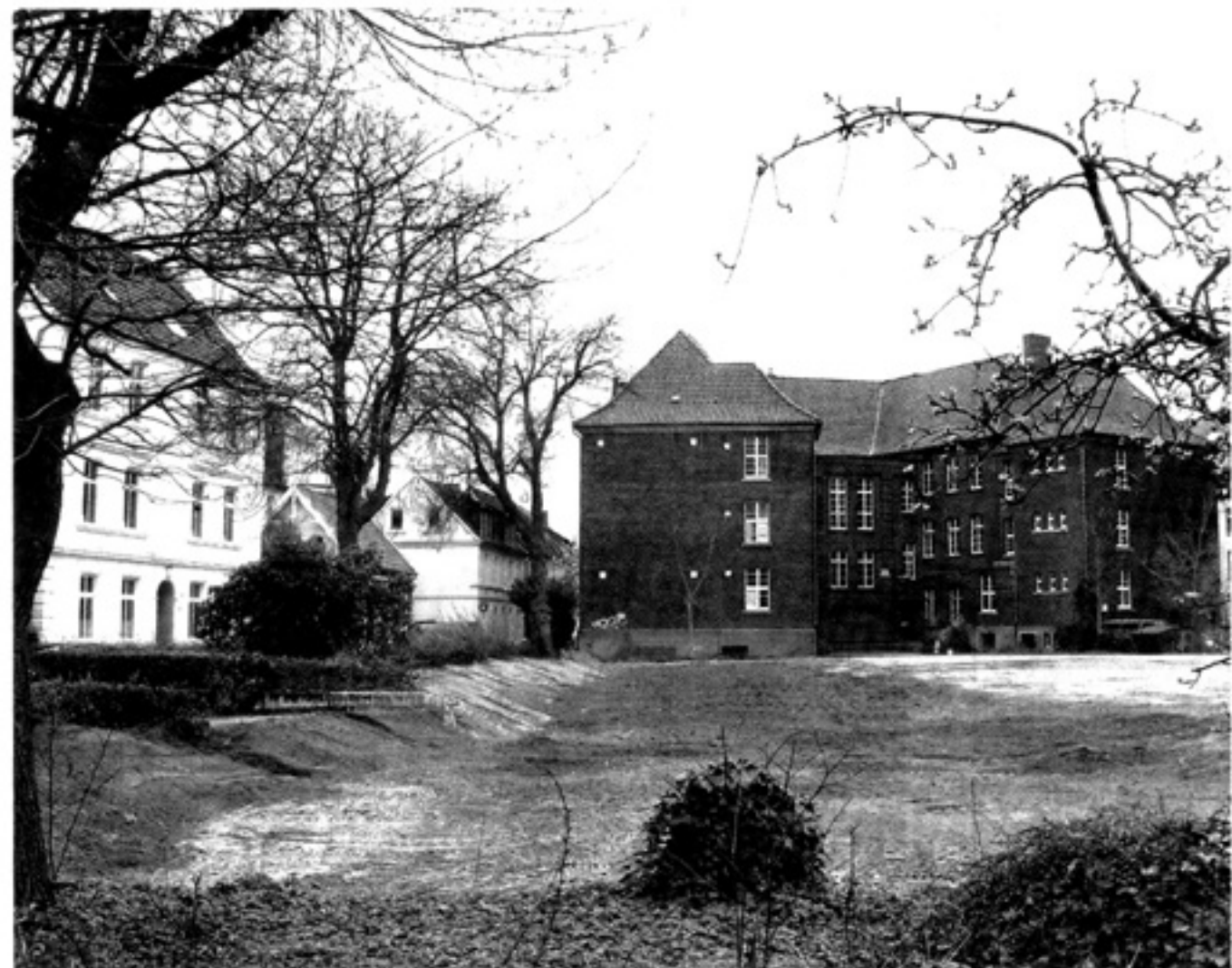
Klassentrakt und Turnhalle der Realschule im Kreuzviertel sind bereits abgerissen worden. An ihrer Stelle soll – unter Einbeziehung der Eichendorffschule (hinten) ein neues Quartier entstehen.
